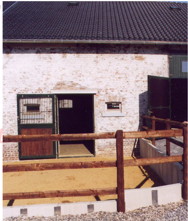
Kuhstallumbau – hier wurden wenigstens die Türober- teile verglast.
